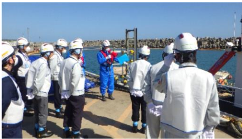
(写真1-1) 東京電力から説明を受けている状況 (新たに設置した垂直梯子付近)
