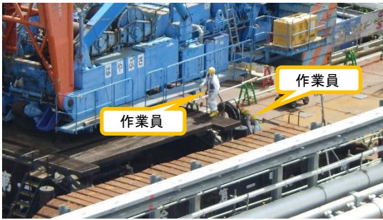
(写真5-2) クレーンの点検の状況
