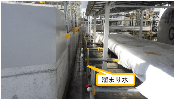
(写真3-2) 内堰と外堰の間の状況
