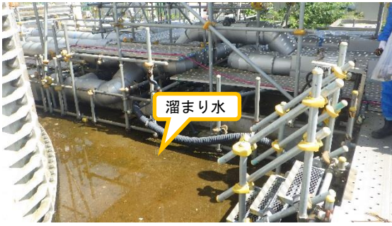
(写真3-1) 内堰内の状況
