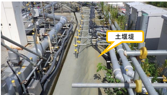
(写真 2 - 3) 東側の外堰の状況 (南側から撮影)
