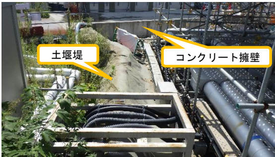
(写真 2 - 2) 南側及び東側の外堰の状況 (北側から撮影)
