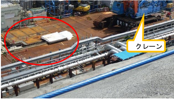
(写真5-1) クレーンの停留場所 解体工事時は赤丸の位置にクレーン が設置されていた
