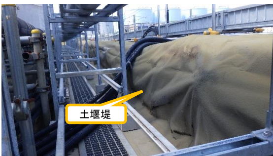
(写真 2 - 4) 北側の外堰の状況 (東側から撮影)
