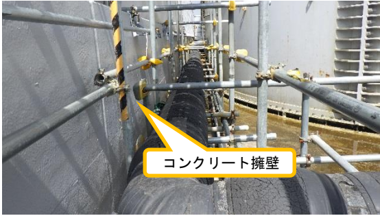
(写真 2 - 1) 西側の外堰の状況 (南側から撮影)
