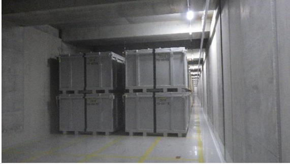
(写真 2 - 2) 貯蔵庫の状況② (地下 1 階の貯蔵レーンでの保管 状況の例)
