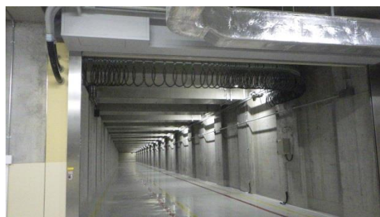
（写真2）地下1階フロアの状況
