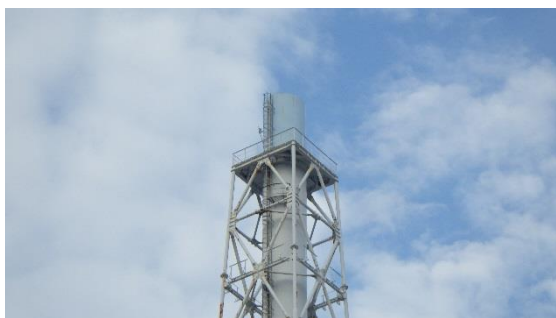
(写真6-2) 解体後の排気筒 (9月1日 16時 28分頃撮影)
