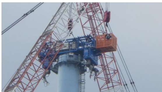
(写真3-2) 写真3-1赤丸印拡大 解体装置の端に接合し固定され、安定した状態で作業が行われた
