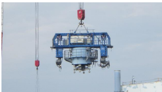
(写真4) 15時36分頃撮影 解体装置に把持され吊り下ろされる頂部ブロック。
