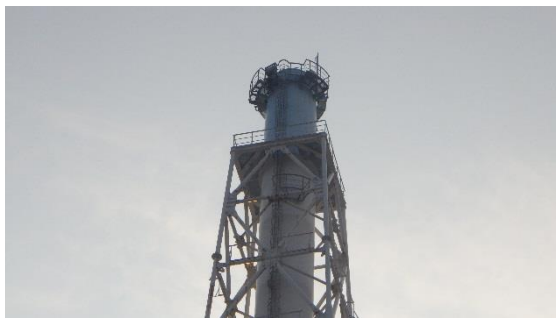
(写真6-1) 解体前の排気筒 (8月1日撮影)
