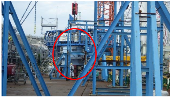
(写真5) 16時15分頃撮影 赤丸部分に頂部ブロックが着座している
