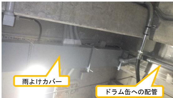
(写真2-1) 天井部分の亀裂からの雨水流入対策のため、雨よけカバーを設置し(写真2-2)の雨漏れ受けドラム缶に雨水を貯蔵するようになっている
