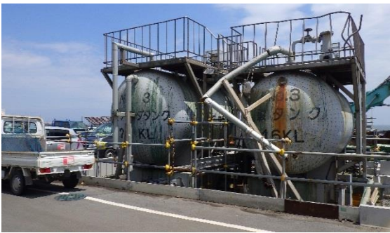
(写真4-1) 前回撮影(5月15日撮影) 南西側から撮影
