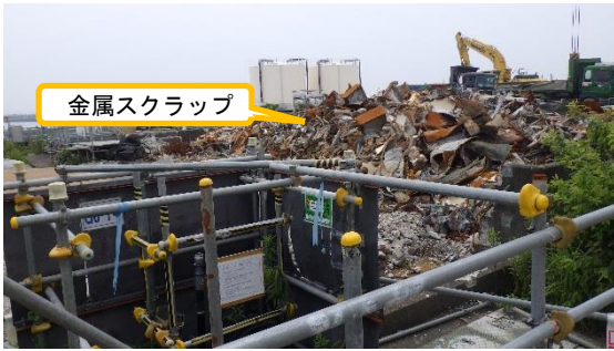
(写真3-3) 写真3-2の黒丸部分拡大(北西側から撮影)
