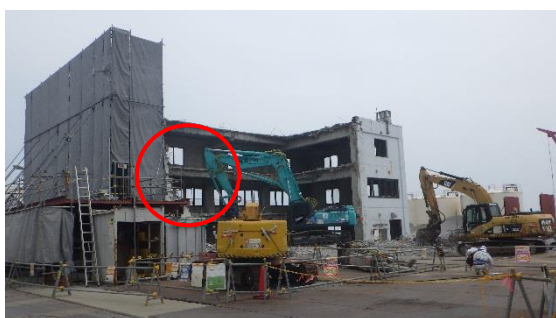
（写真1－2） 今回撮影（7月31日撮影） 写真1－1赤丸部分の工事が進捗していた
