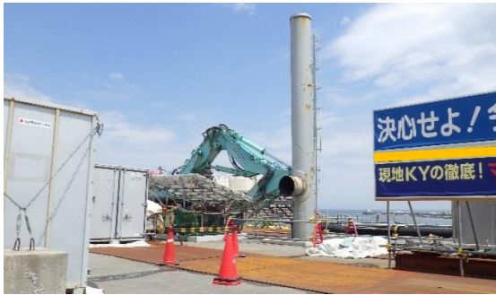
(写真5-1) 前回撮影(5月15日撮影) 南西側から撮影
