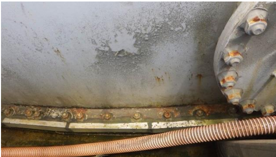
(写真 2 - 3) タンク側板及び底部の表面の状況 (A 1 タンクの例)
