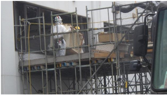
(写真1-3) 物品撤去の様子
