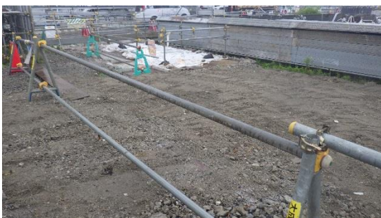
(写真2-3) 2号機油分離槽建屋跡地
