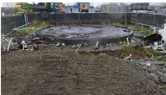
(写真2-2) 軽油タンク跡地
