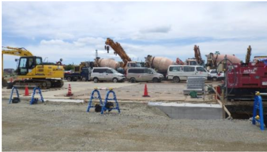
（写真1－1）北側から駐車場の中央部付近を撮影
