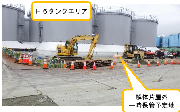
(写真2) 解体片屋外一時保管予定地の状況 (H6タンクエリア北東側から撮影、写真右側がH5タンクエリア)
