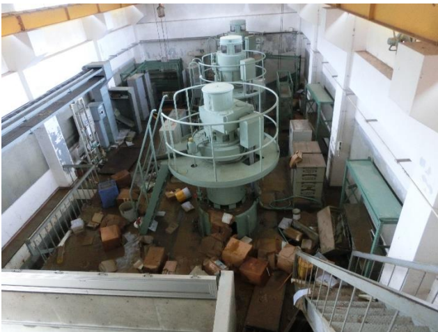
台風による被災の状況（令和元年10月） ポンプ場内部の様子(左) ポンプ場の浸水の様子(右)
