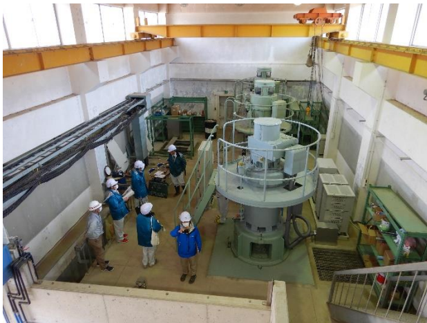
復旧したポンプ(一番手前)（令和2年4月）
