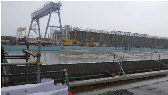
（写真1-1）堰に飛散防止剤(水色)が塗布されている。（北東側から撮影）
