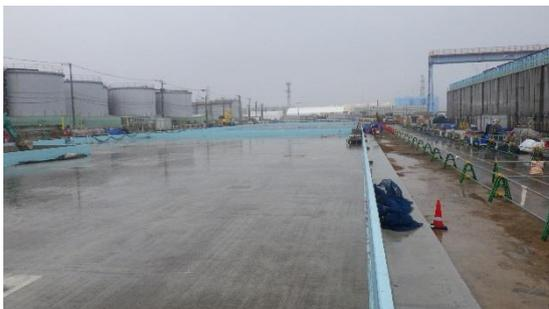
（写真1-2）左に見えるのはJ1タンクエリア。同様に堰に飛散防止剤(水色)が塗布されている。（南側から撮影）
