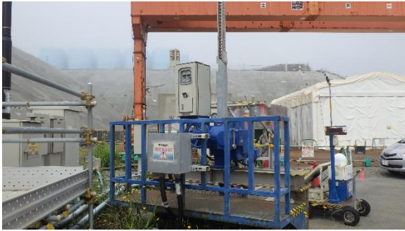
(写真3) K排水路ゲートの状況 (東側から撮影)
