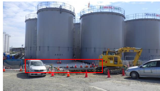
(写真 3 - 2) 平成30年10月5日撮影 ※赤枠内はコンクリート基礎工事が進 捗していた箇所
