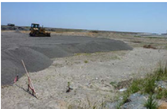
(北海老地区工事実施状況)
