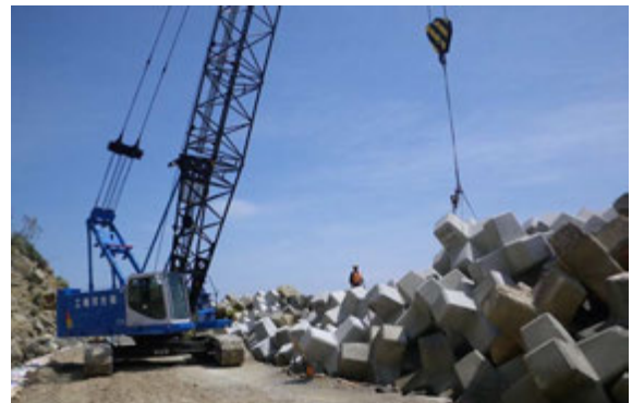
(下長沢地区工事実施状況)
