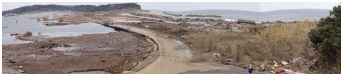
(鹿島地区被災後状況)
