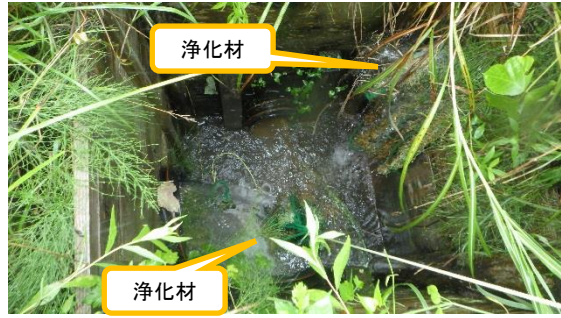
(写真 2 - 2) 排水柵の状況②
