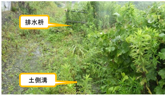
(写真 2 - 1) 排水柵の状況①
