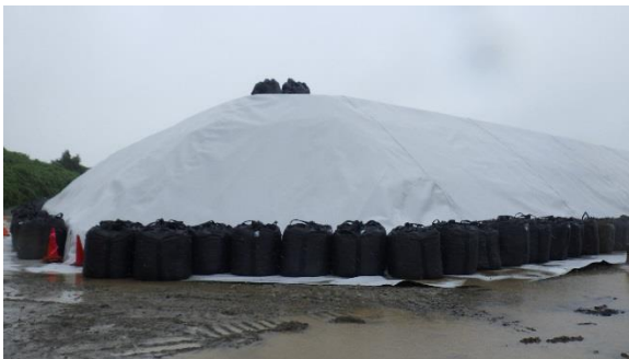
(写真1-1) 北東側エリアのシート養生の状況①
