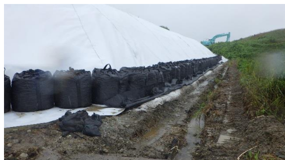
(写真1-2) 北東側エリアのシート養生の状況②
