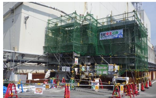
(写真 3 - 2) 施工中 (平成30年 7 月 3 日 撮影)
