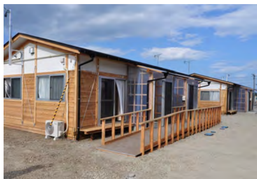
木造応急仮設住宅
