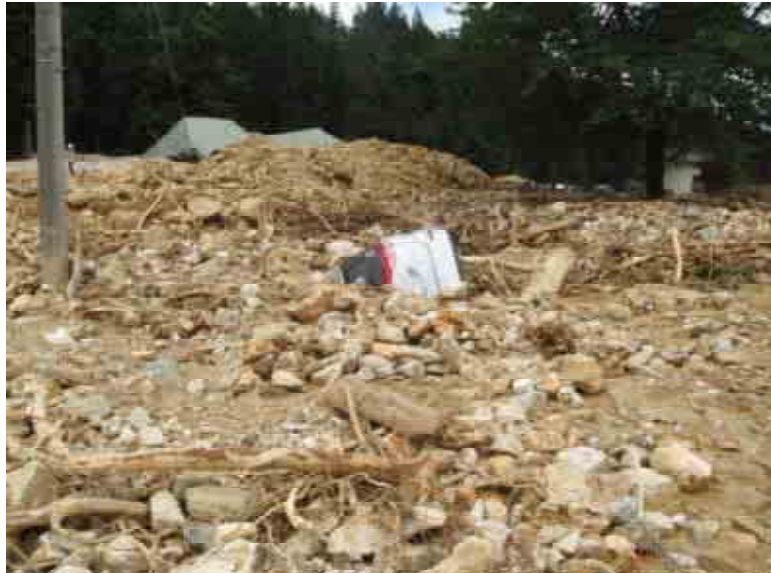
< 林地の被災状況 >
