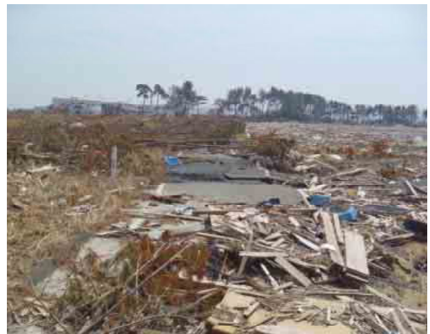
津波による林道の被災状況 相馬市
