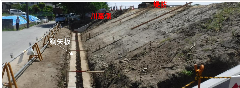
川裏側 鋼矢板打設完了
