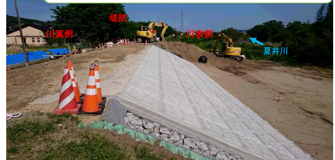
川表側 コンクリート張ブロック完了
