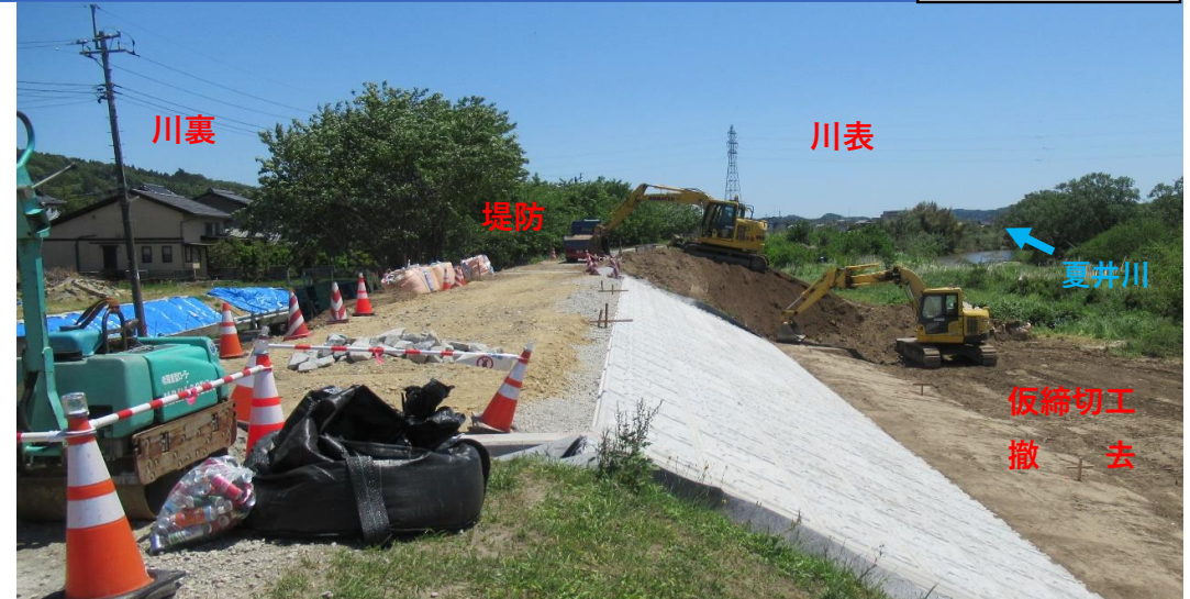
川表側 コンクリート張ブロック完了 川裏側 鋼矢板打設中施工状況
