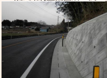
国道294号 (白河市・白坂工区)
