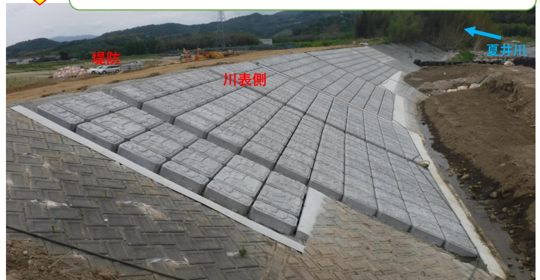
川表側 コンクリート張ブロック完了
