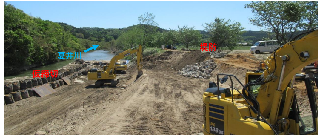
仮締切設置完了、堤防盛土施工中
