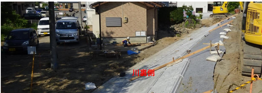
川裏側 コンクリート張ブロック施工状況
