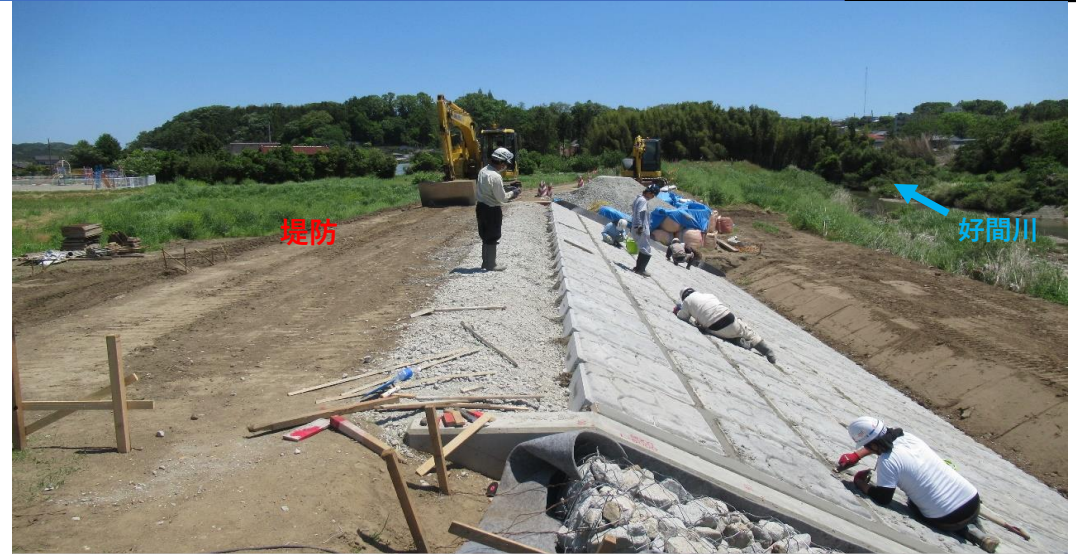
川表側 コンクリート張ブロック施工中 施工状況 (令和2年5月14日)
