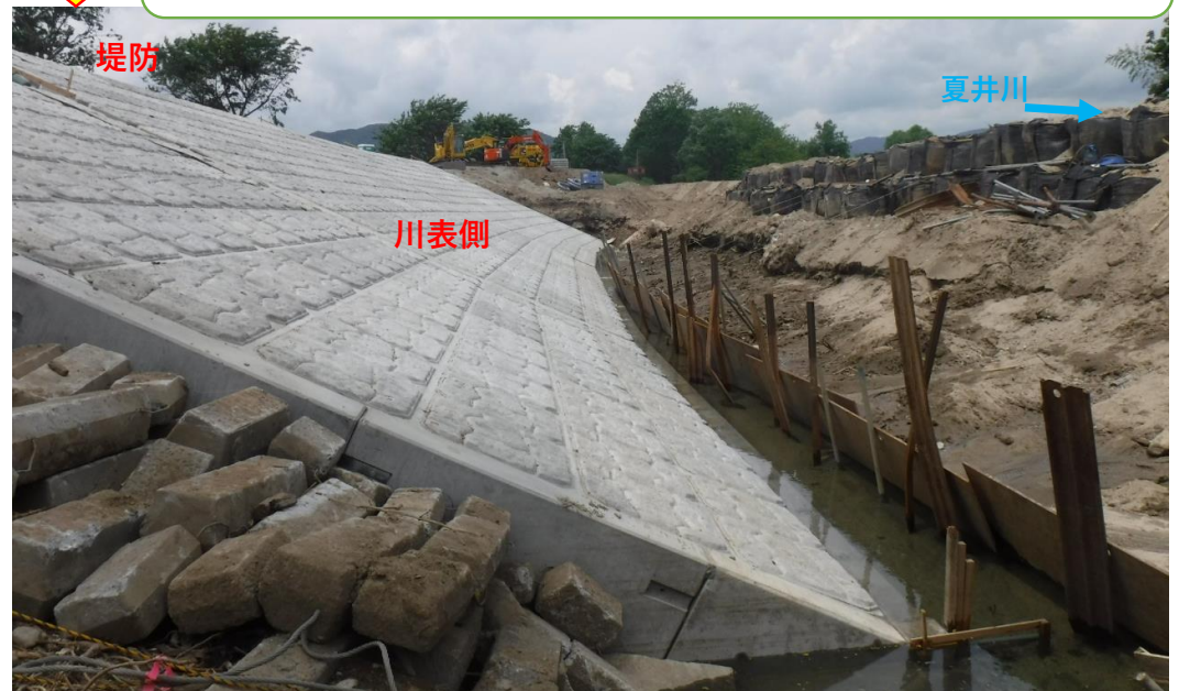
川表側 コンクリート張ブロック完了
