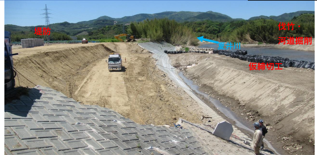
川表側 堤防盛土施工中
