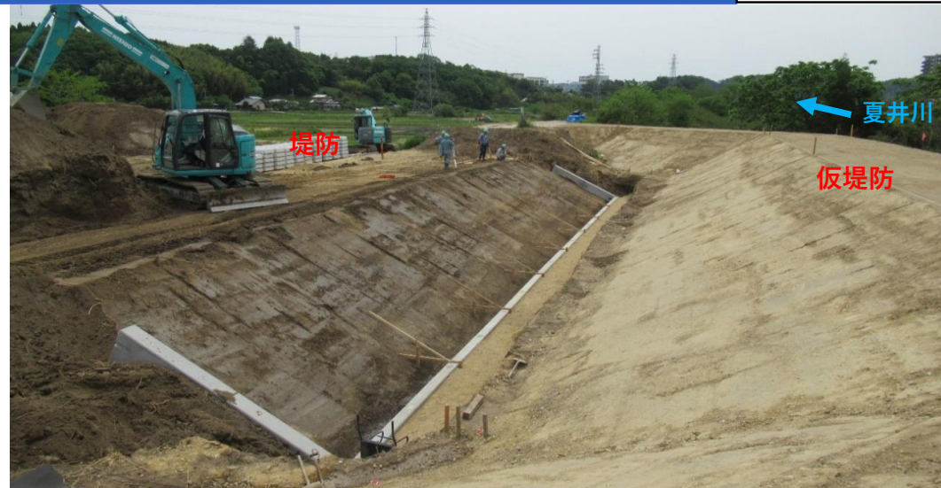
川表側 コンクリート張ブロック着事前
