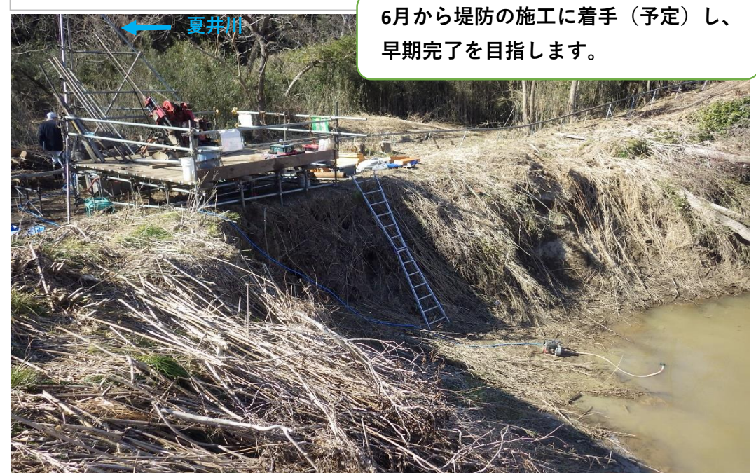
地質調査 ボーリング調査
