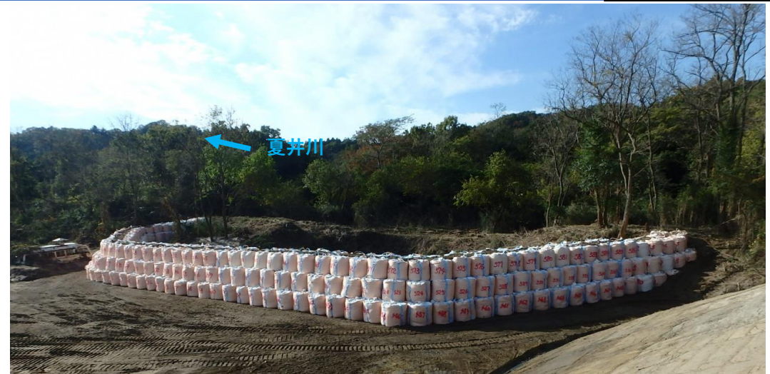
応急仮工事完了 大型土のう設置
