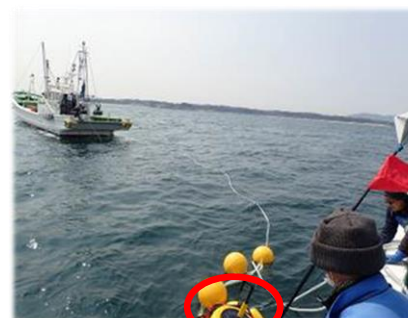
〔ブイの設置作業(目印の赤い旗と、黄色い浮きが付いています)〕
