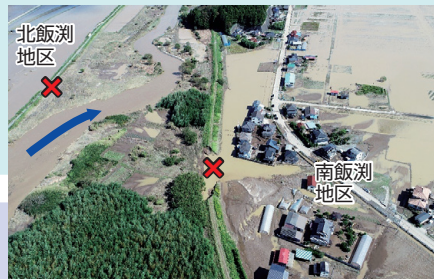
破堤により家屋等の浸水被害が発生
