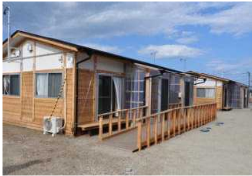
木造応急仮設住宅
