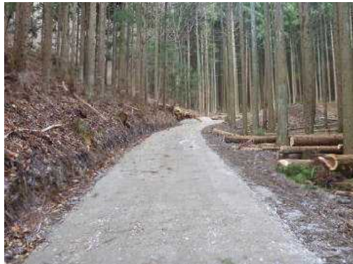
作業道の利用状況(川俣町西福沢地区)
