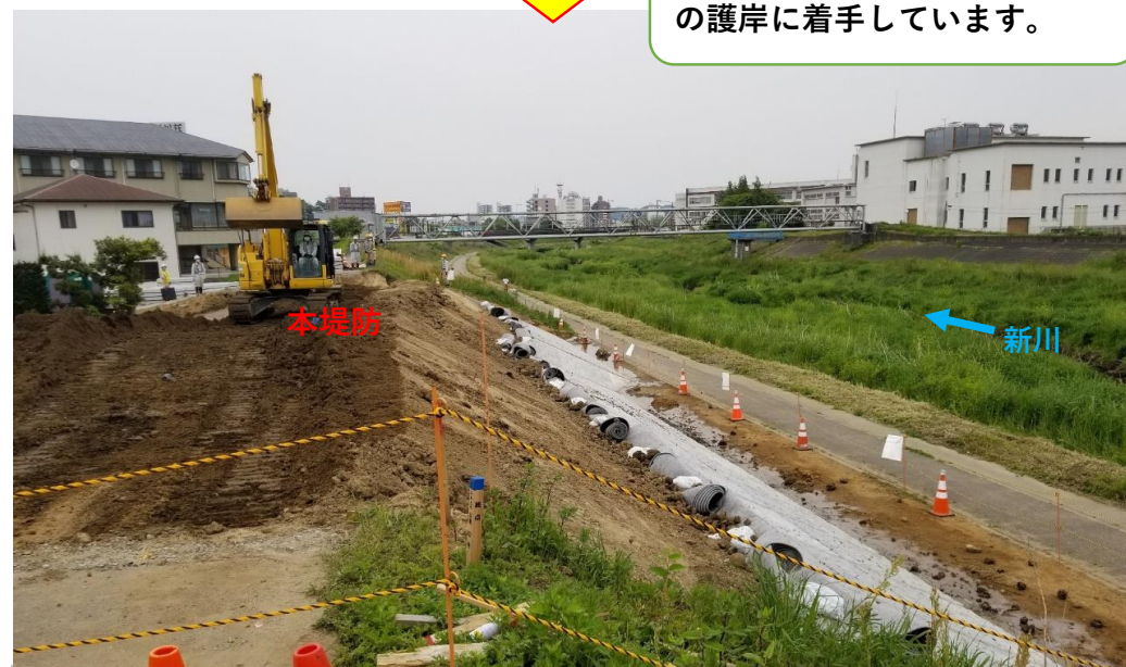
堤防盛土、張ブロック施工中
