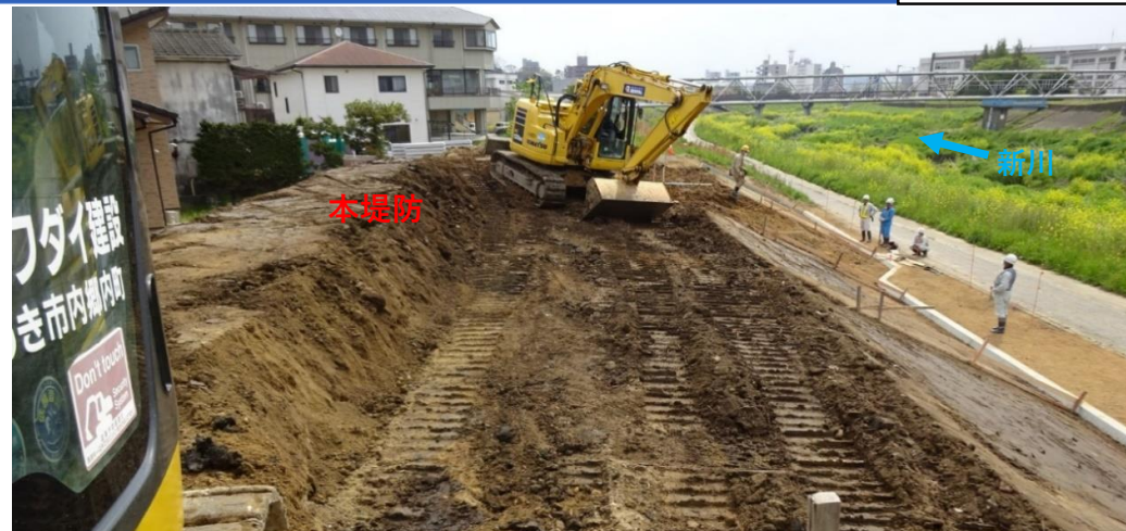
堤防盛土施工中 張ブロック施工中
