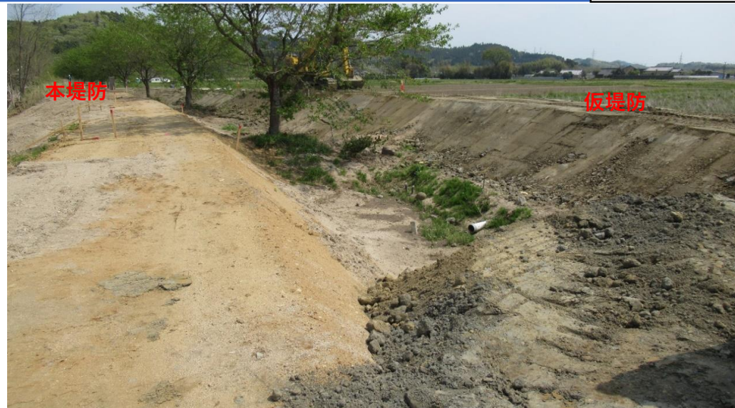
仮堤防設置完了、堤防盛土施工中
