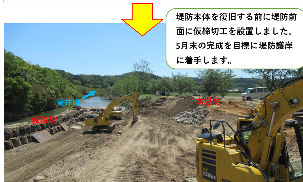
仮締切設置完了、堤防盛土施工中
