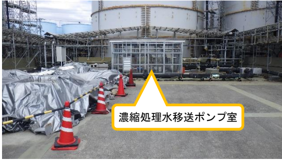
(写真1-1) 濃縮処理水移送ポンプ室外観 南側から撮影
