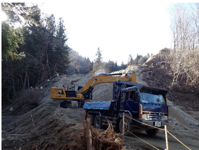
小島地区の工事現場の様子
