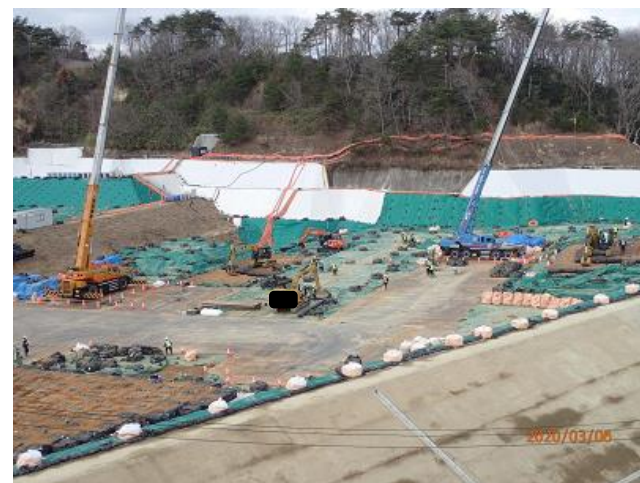
下流側埋立地の埋立状況の確認
