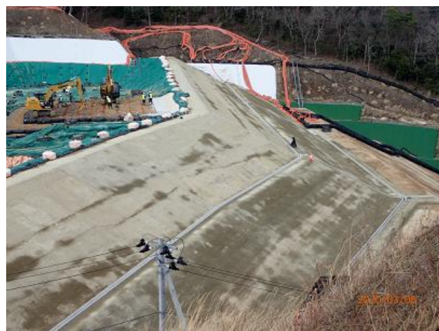
土堰堤の状況確認
