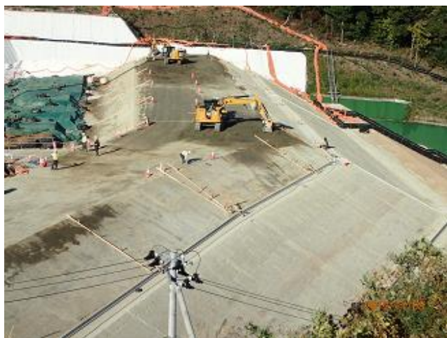
土堰堤の築堤状況の確認
