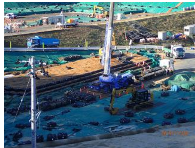
下流側埋立地の埋立状況の確認
