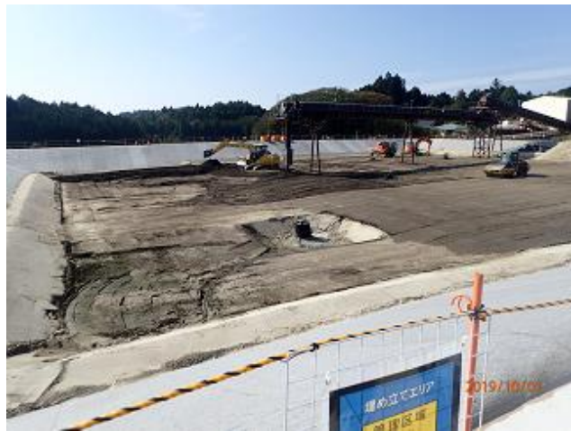
土壌貯蔵施設の稼働状況の確認
