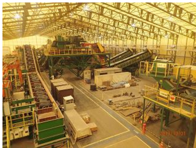
受入・分別施設の稼働状況の確認
