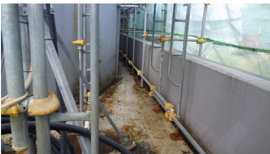
(写真3) (写真2-1)の出入り口付近の堰内の様子
