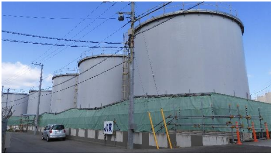
(写真1-1) タンクエリア外観 (南側から撮影)
