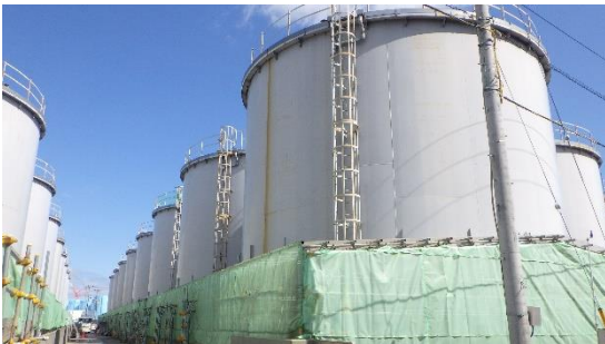
(写真1-2) 同上(西側から撮影)
