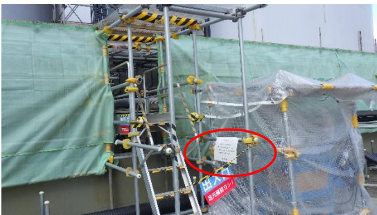
(写真2-1) 堰内への出入り口の例。赤丸内は注意喚起表示。
