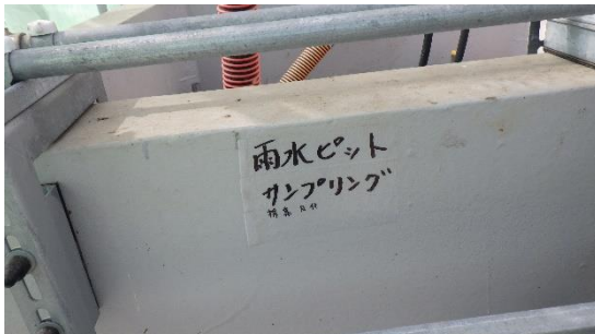
(写真4-3) (写真4-2)の内堰内雨水集水ピット外壁に堰内サンプリング箇所である旨の表示があった。
