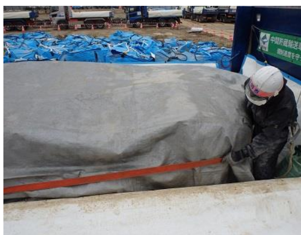
除去土壌等の飛散・流出防止対策
