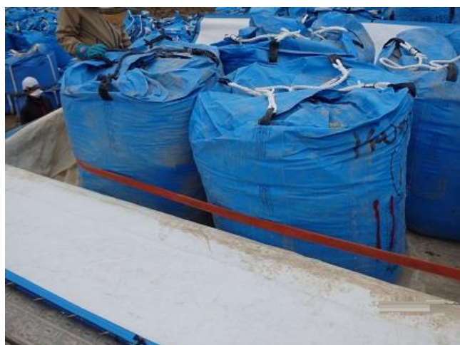
除去土壌等の積込作業
