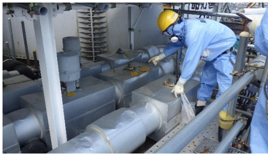
(写真 1 - 1) 排水ラインの弁の確認状況
