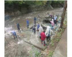
【住民による土砂撤去作業】
