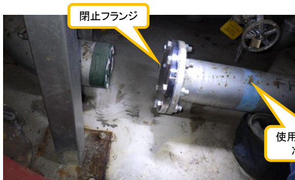
(写真1-1) 閉止フランジの取り付け状況
