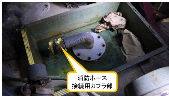
(写真1-2) 取り外された消防ホース接続用カプラ部配管
