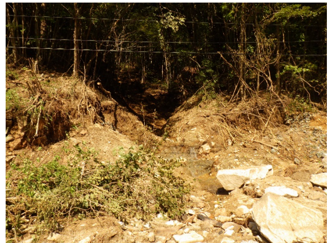
山腹斜面の崩壊（相馬市）
