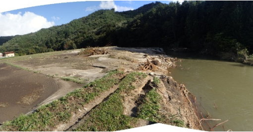
小白井川の越水による田への土砂流入 (川内村)
