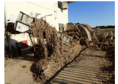
和田排水機場への浸水 (相馬市)
