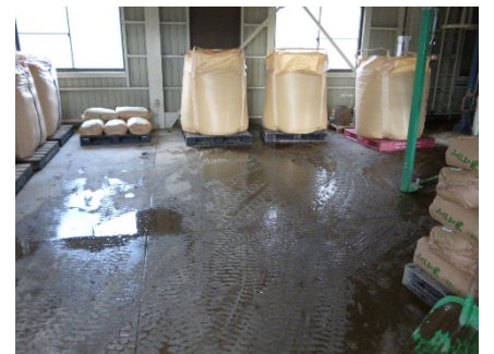
ライスセンターへの浸水 （川内村）
