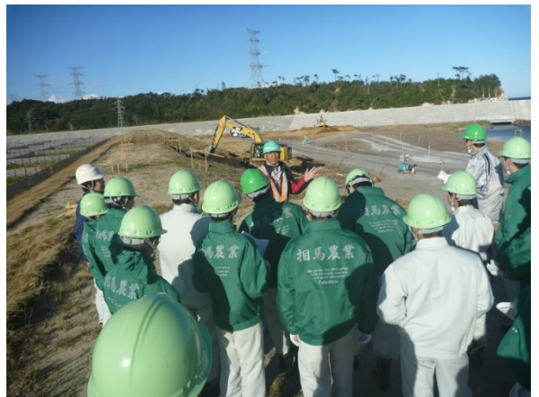
現場担当者による盛土工の説明
