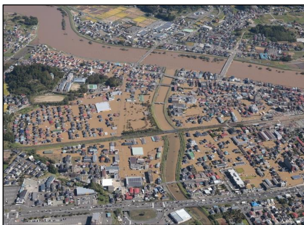
本宮市内浸水状況
