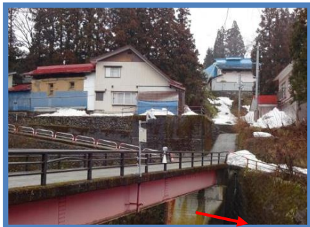
(西会津町 長谷川 吉田橋)
