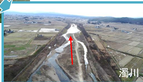
濁川(喜多方市) 河道掘削、伐木状況
