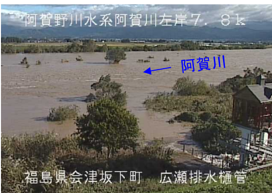
出水状況 広瀬排水樋管付近
