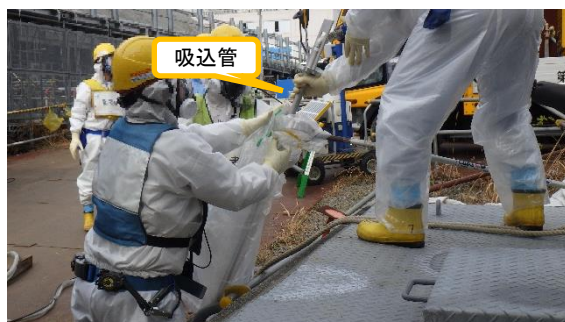
(写真2-2) 取り外された吸込管 (ビニール袋で養生されている)
