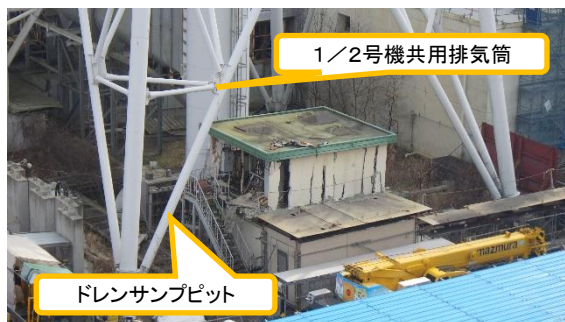
(写真1-1) 排気筒周囲の状況
