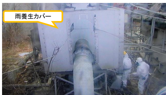
(写真2-1) 作業中の状況 (遠隔カメラから確認)
