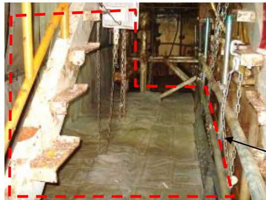
対策後の様子
