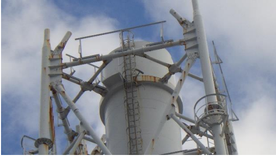
(写真3) 排気筒頂部の状況
