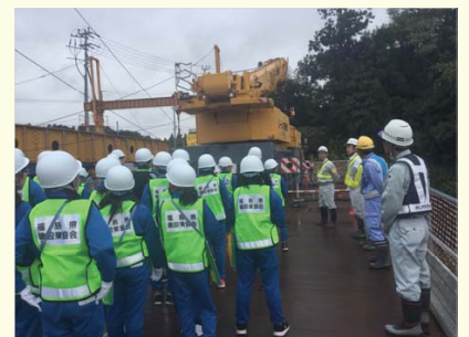
建設現場見学会
