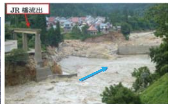
JR橋流出 只見川(金山町) 【出水状況(H23.7月)】
