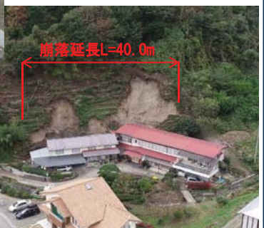
下名目津3号（二本松市） 【台風19号による被災状況】
