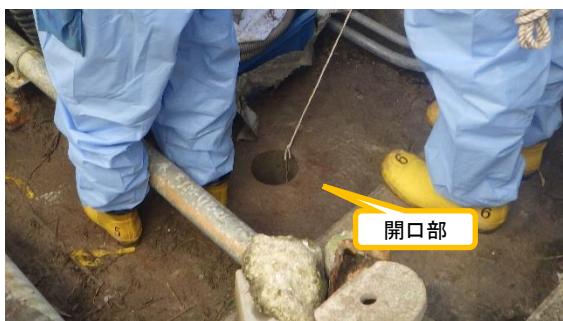
(写真1-2) 開口部の状況
