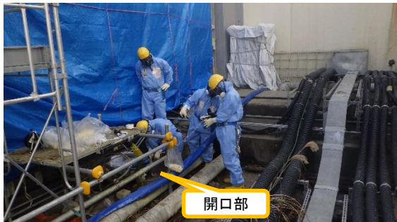
(写真1-1) 作業状況
