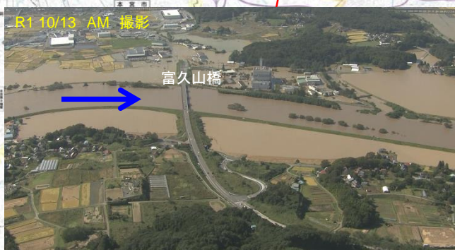
②富久山橋付近(81kp付近)
