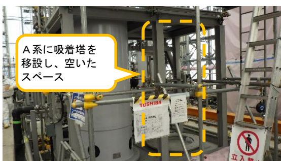
(写真 1 - 2) C系の吸着塔ラック
