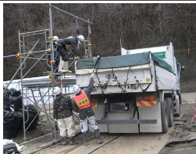
除去土壌等の飛散・流出防止対策
