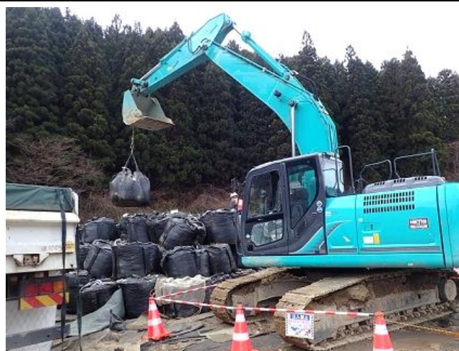
除去土壌等の積込作業
